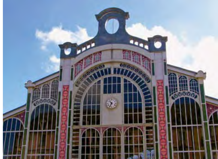
Gußeisen nach Gustave Eiffel – Markthalle in Belfort
